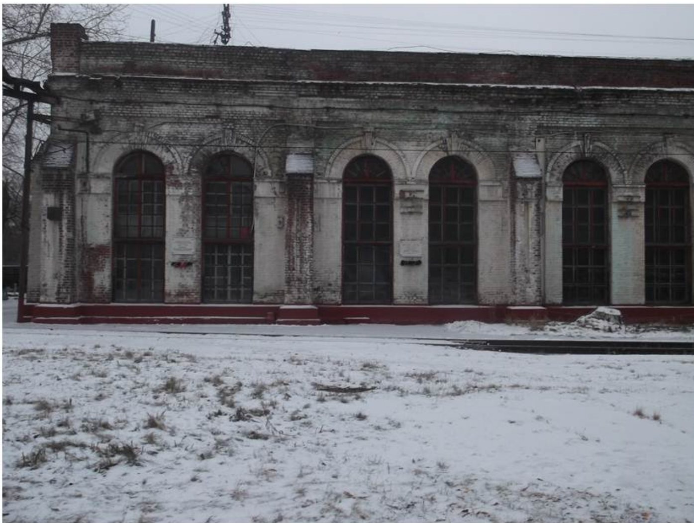
Старое здание паровозовагоноремонтного завода
