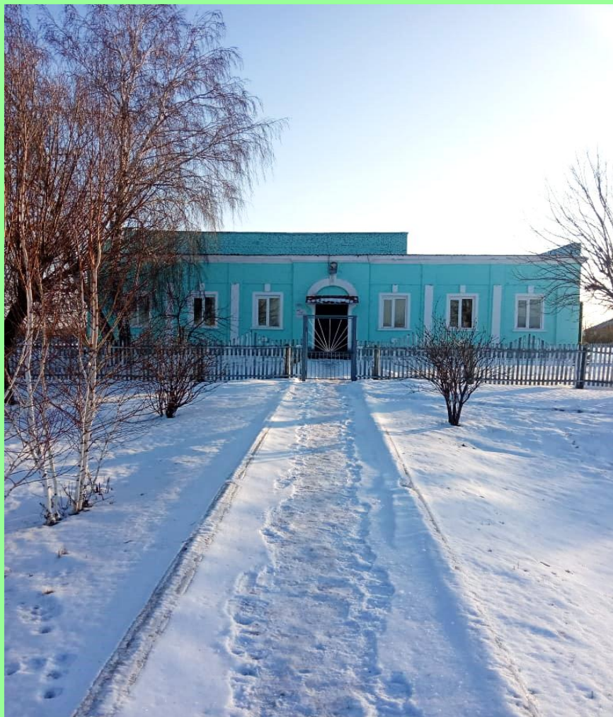
Район контактной сети станция Колония
